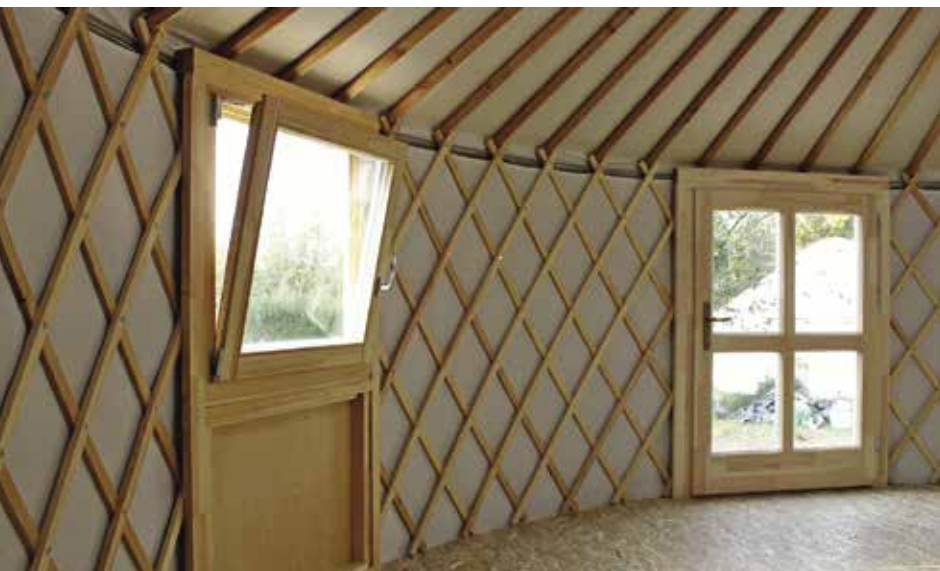
Korszerű nyílászárók a jurtán
